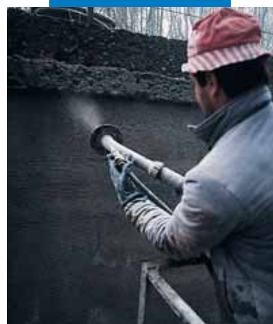
Канал гидроэлектростанции в г. Бертини-Роббьяте (Область Комо): нанесение напылением
