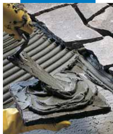
Наружная укладка камня с неровной тыльной стороной с обычным или двусторонним нанесением клея
