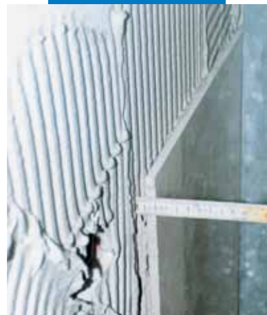
Укладка фарфоровой плитки с нанесением толстого слоя клея
