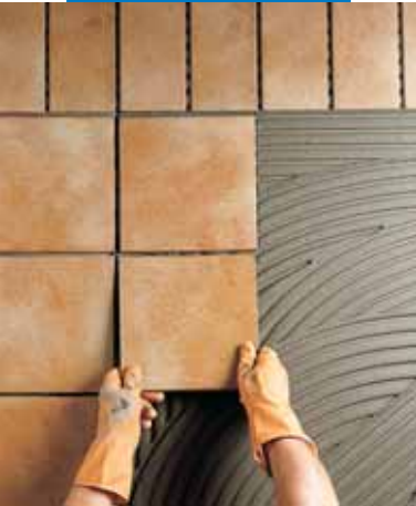
Укладка клинкерной плитки снаружи помещений
